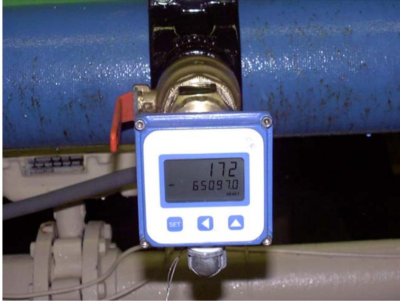
**FIGURE 5-3.** Filter Effluent Flow Meter
