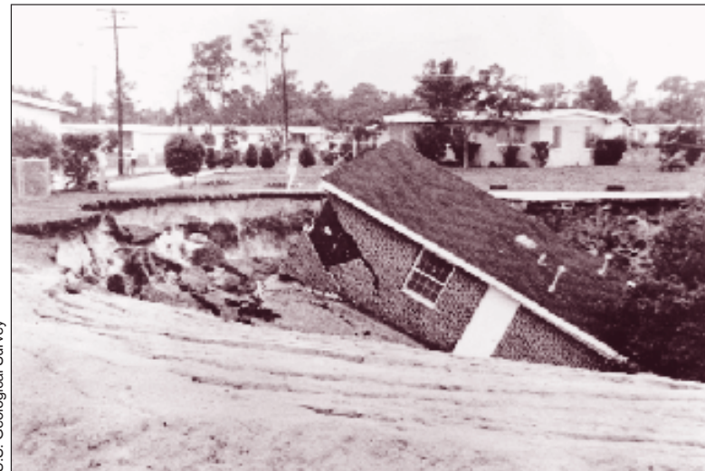
La construcción sobre suelos inestables puede tener serias consecuencias ambientales.
