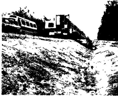
El excavador hidráulico Hydro-Scopic cava las zanjas nuevas y mantiene las viejas sin interrumpir el tráfico.
