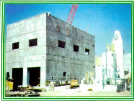
**Planta Internacional de Tratamiento de Aguas Residuales de South Bay, San Diego, California, EE.UU. La construcción del edificio de obras de cabecera y equipos de control de olores.**
