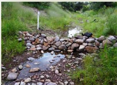
Una estructura para control de erosión de rocas proporciona un aumento localizado en la infiltración de agua en las montañas de Chiricahua. **Cortesía de:** Sky Island Alliance.
